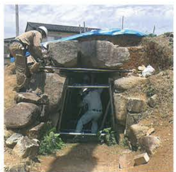
天井石の再設置作業の様子
