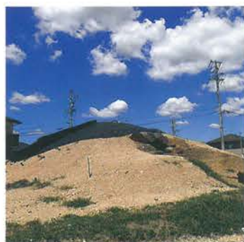
墳丘整備工事の状況(防水シート等設置中)
