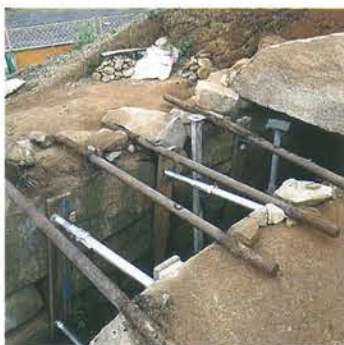
天井石取り外し後の石室
