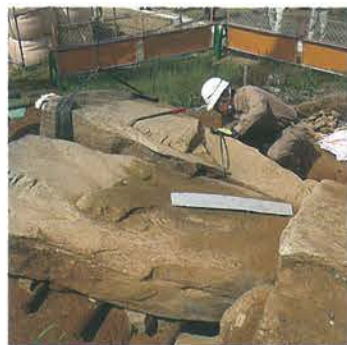
天井石取り外し作業の様子
