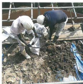
崩積土の除去作業の様子
